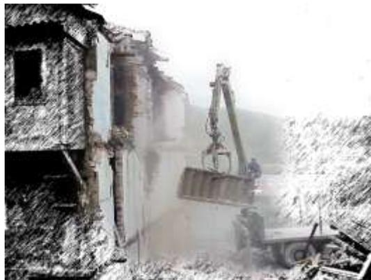
Figura 65. Ilustración de la retirada selectiva de estructuras de madera de un edificio
