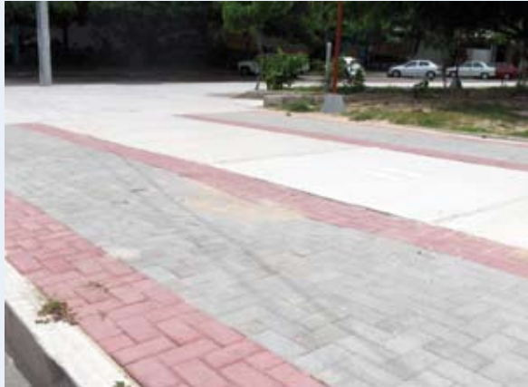
Contrato para la reconstrucción de andenes del parque Río Mar con cargo a los recursos del SGP para APSB.
