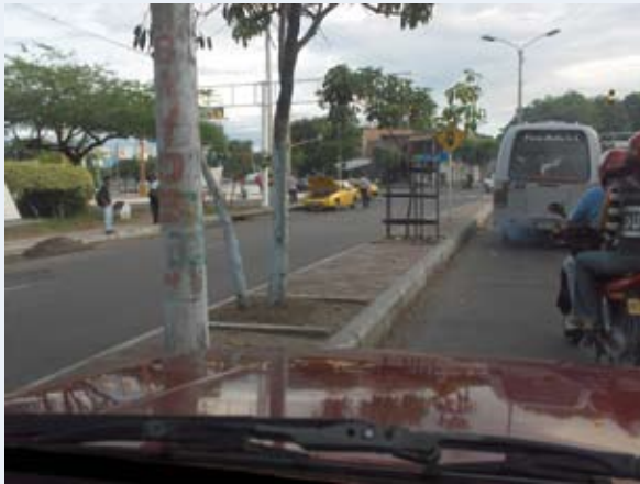
Obras de equipamiento vial cuya disposición hace parte del alcance de los contratos.
