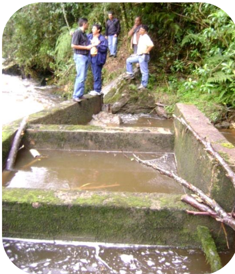
Foto. Rodrigo Torres – profesional Comunicaciones IAF. Proyecto de construcción del acueducto de Moniquirá en el departamento de Boyacá.
